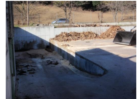
Foto 9: Carga de camiones por gravedad
