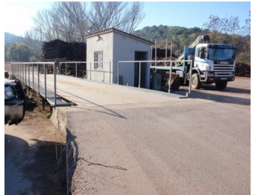
Foto 1: Báscula para el pesaje de camiones u otros vehículos con leñas
